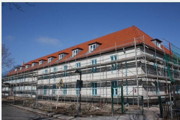
Während der Sanierungsarbeiten
