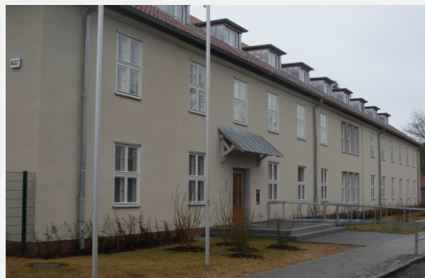
Nach Abschluss der Arbeiten
