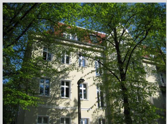
Nach Abschluss der Arbeiten
