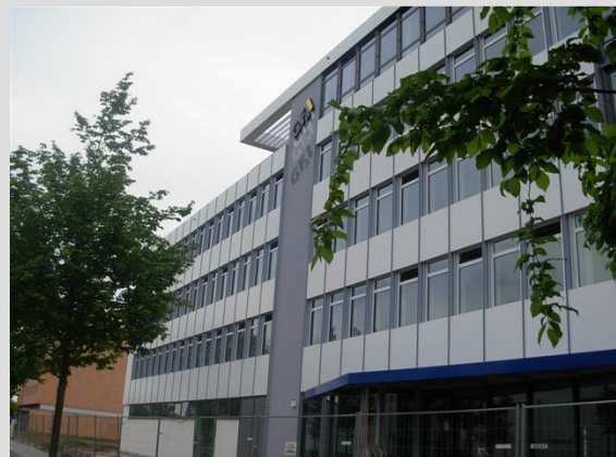
Nach Abschluss der Arbeiten
