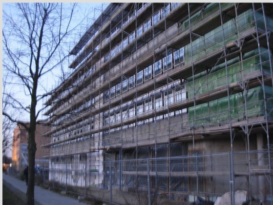
Ein Blick auf die Fassadenarbeiten
