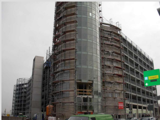
Ein Blick auf die Fassadenarbeiten
