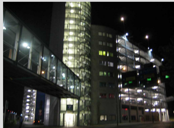
Nach Abschluss der Arbeiten
