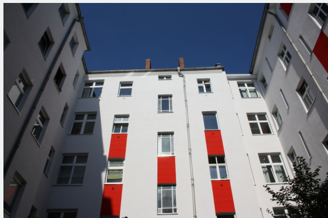
Nach Abschluss der Arbeiten
