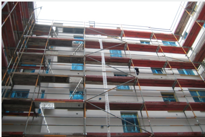
Während der Sanierungsarbeiten
