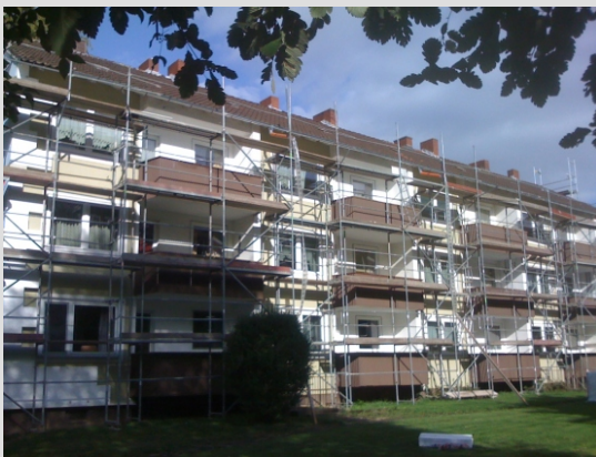
Ein Blick auf die Sanierungsarbeiten
