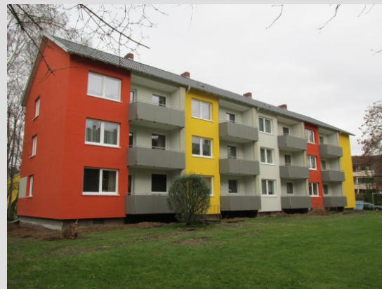
Nach Abschluss der Arbeiten Vorderansicht
